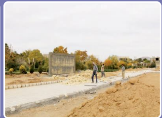
اجرای عملیات عمرانی فاز ۲ باغ گلها
