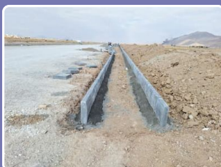
اجرای جدولگذاری فاز ۲ بلوار سلمان فارسی
